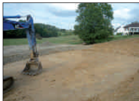
La mise en forme du fond du bassin est prête
