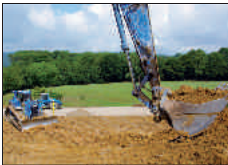
Les premiers travaux démarrent
