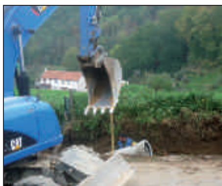
La pose du collecteur de Ø 500 mm
