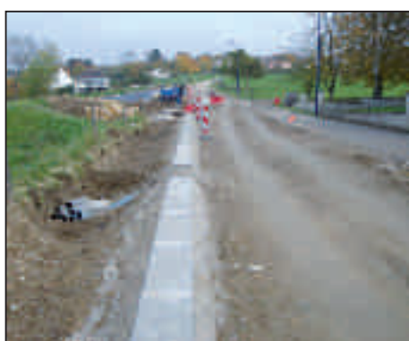
Les caniveaux en cours de pose
