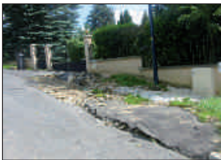
La construction du bassin d'orage permettra d'éviter le renouvellement de tels dégâts
