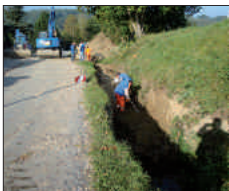
Elargissement du fossé en vue de la pose du collecteur
