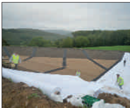
Un géotextile protège la membrane
