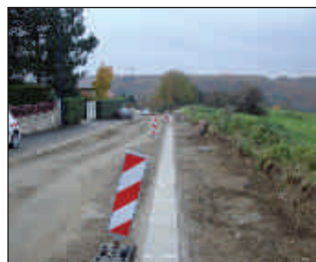
Le collecteur est enfoui permettant l'élargissement de la voirie
