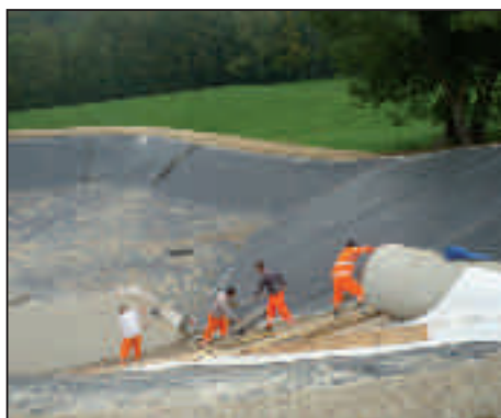
On sécurise l'arrivée des eaux
