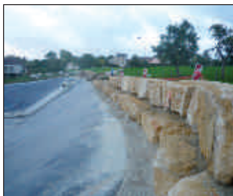
Un enrochement assure la sécurité sur le bord de la route
