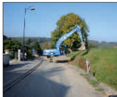
Reste à canaliser le fossé
