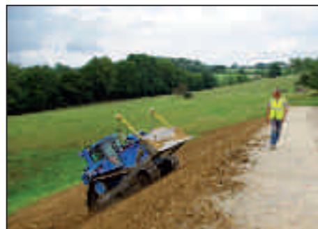
On peaufine le profil de la digue
