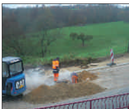
Mise à hauteur des regards de visite
