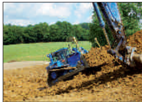
Les engins sont guidés par satellite suivant le plan établi par le bureau d'études
