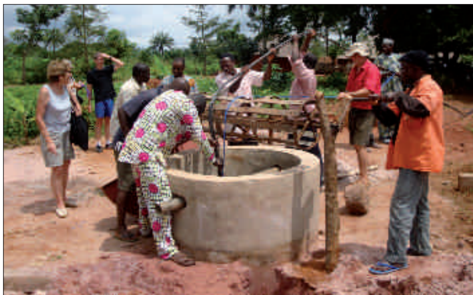
La pompe à eau en cours de pose dans le puits de 60 mètres de profondeur
