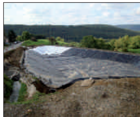
La membrane d'étanchéité en cours de pose
