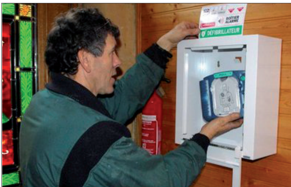
Les appareils sont tous accessibles facilement, chacun abrité dans un simple boîtier
