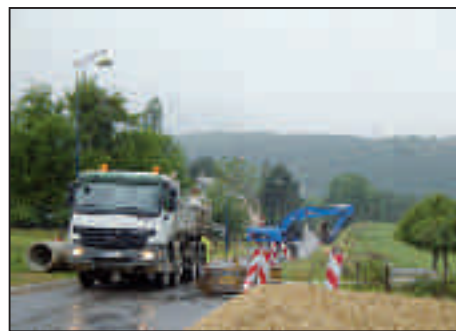
Après trois années de préparations administratives et techniques, les engins de TP arrivent
