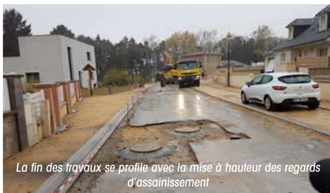
*La fin des travaux se profile avec la mise à hauteur des regards d'assainissement*
