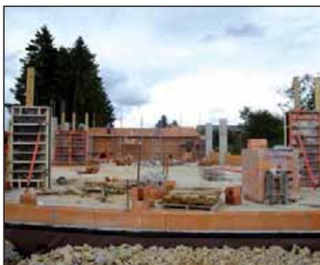
*La brique "monomur" utilisée permet d'isoler durablement et fait "respirer" les bâtiments*
