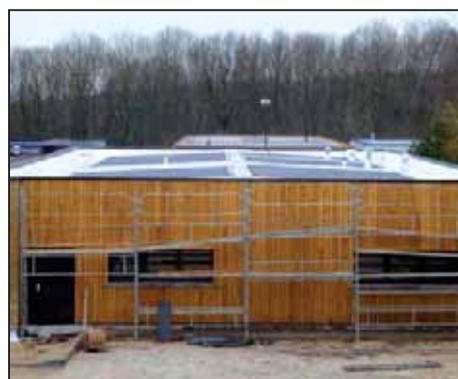
*Les bandes noires sur le toit sont les capteurs photovoltaïques*
