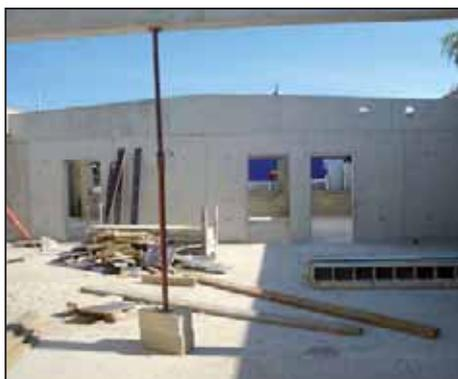
*L'isolation phonique a nécessité la construction de murs en béton banché*
