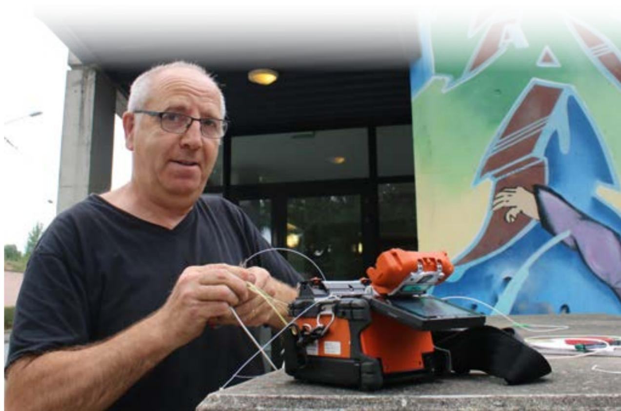
Un technicien d'Orange soude un brin de fibre optique
