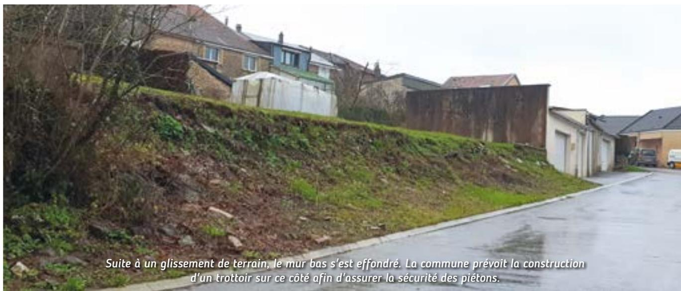
*Suite à un glissement de terrain, le mur bas s'est effondré. La commune prévoit la construction d'un trottoir sur ce côté afin d'assurer la sécurité des piétons.*
