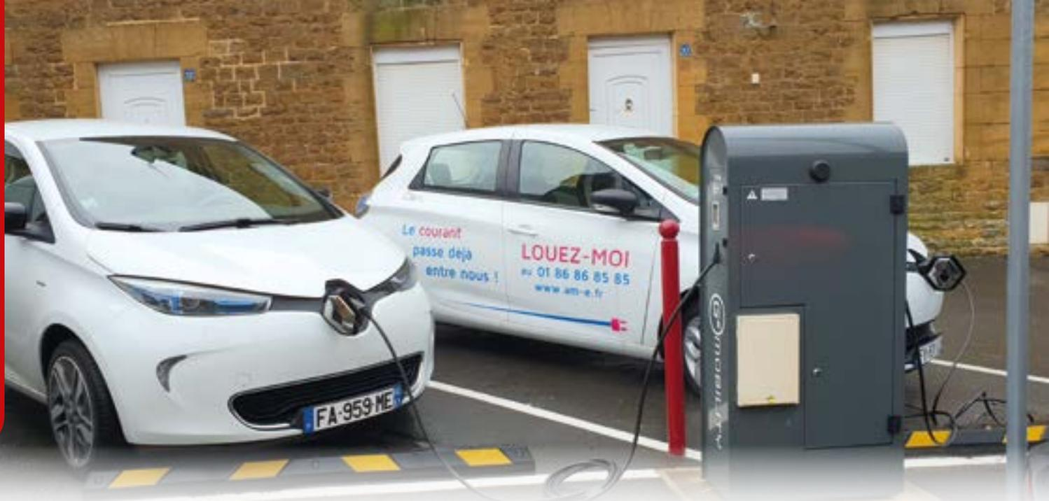
Deux véhicules électriques peuvent se brancher sur chaque borne et bénéficier d'une recharge rapide.
