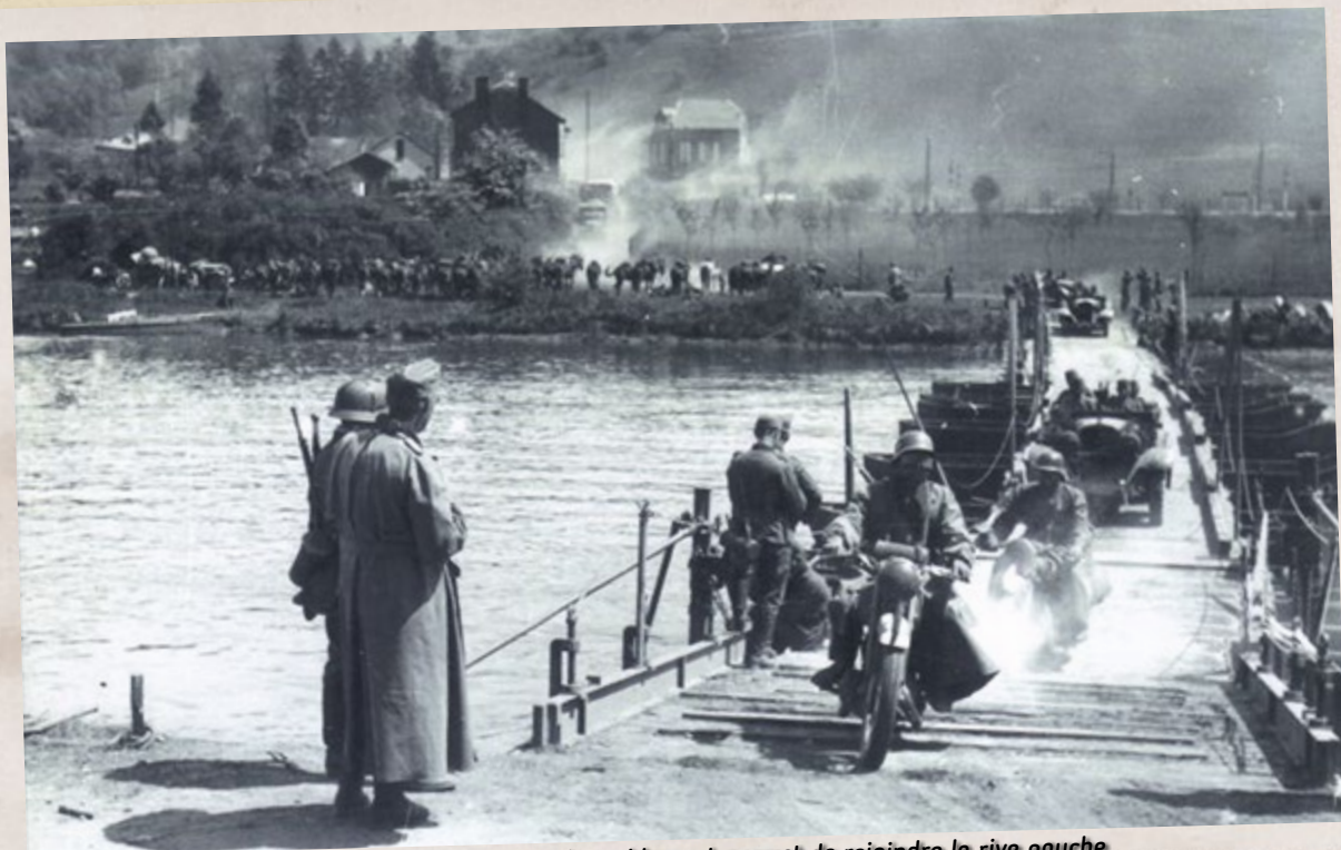
Un pont provisoire construit rapidement permet de rejoindre la rive gauche
