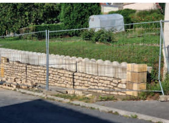
Aussi avec les effets de l'érosion due à la pluie, les fondations des murets implantés en haut du talus se sont trouvées découvertes et sans réelles solidité.
